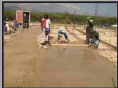
Pouring the slab
